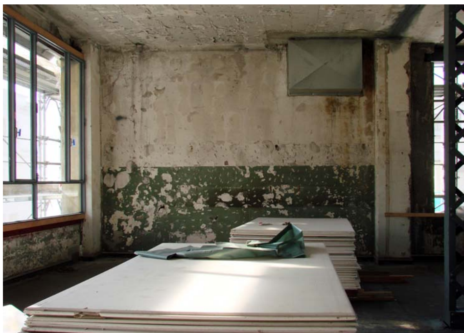
SIP, bâtiment G, 3 e étage, le 07.03.14
